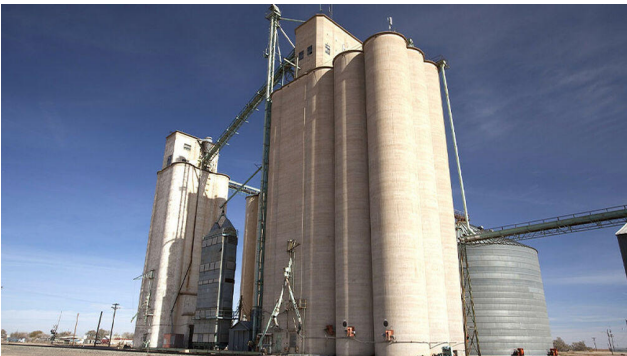
Елеватор / силоси — перша ділянка будь-якого зернового етанолу
