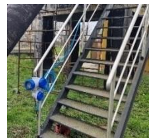
Дистанційна установка польового перетворювача сигналу OPTISONIC 6300
