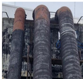
Вимірювання витрати за допомогою затискного датчика на трубі з вуглецевої сталі з бітумним покриттям
