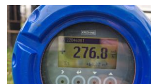
Витрата стічних вод, що відображається ультразвуковим перетворювачем сигналу
