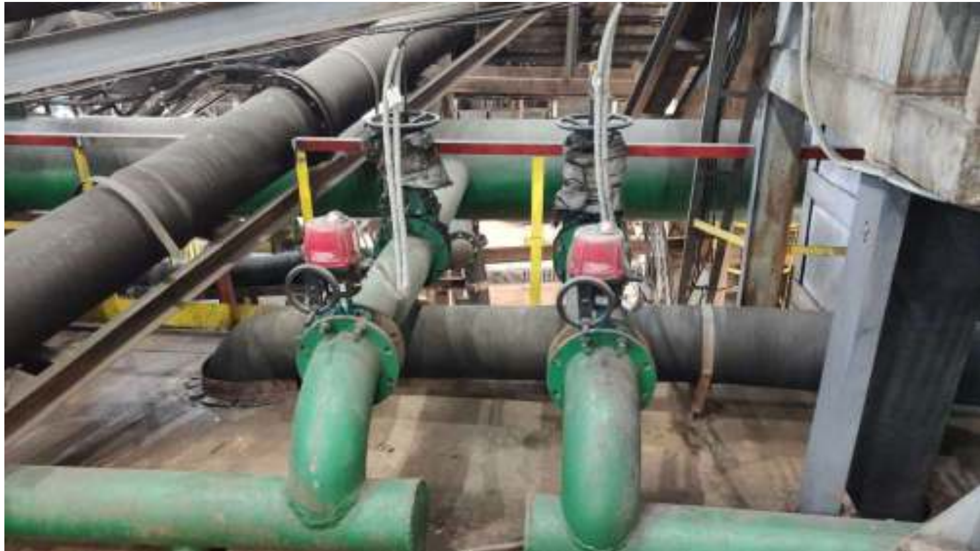
Вигляд секції РЗФ після реконструкції
