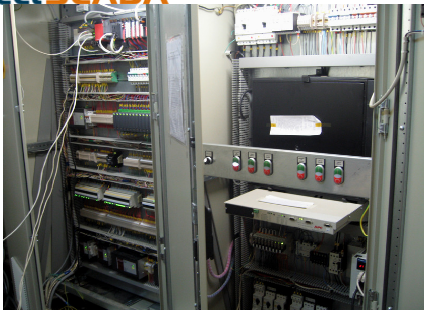
Шкафы управления в процессе наладки
