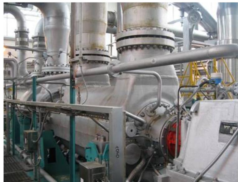
Рис. 3-х ступенчатый центробежный нагнетатель 66ГЦ-1162/1,3-38
