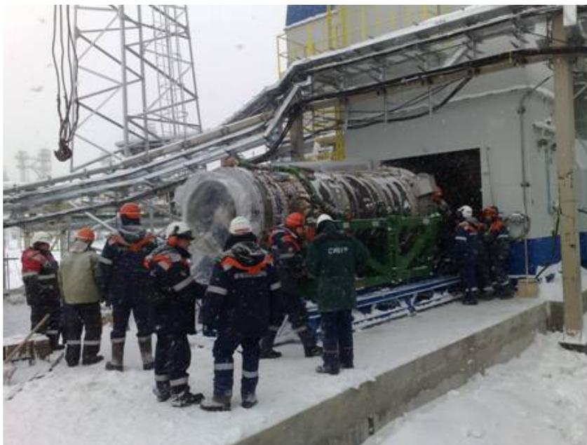
Рис. Закатка двигателя НК-16-СТД к месту установки
