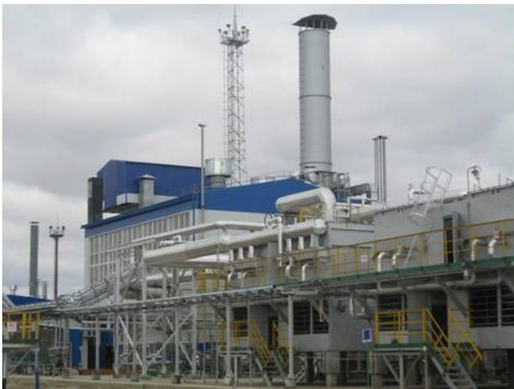
Рис. Легкосборное укрытие агрегата и наружный двор
