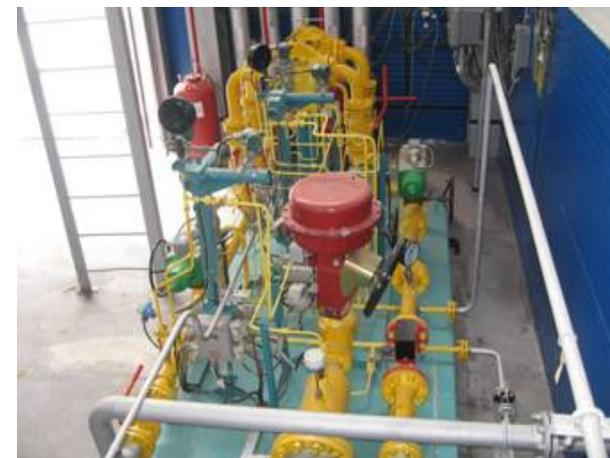
Рис. Блок подготовки топливного и пускового газа
