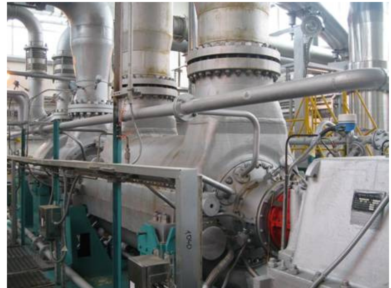
3-stages centrifugal booster 66GC-1162/1,3-38
